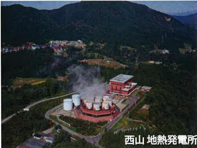
地熱発電は火山のマグマの熱を利用して発生させた蒸気でタービンを回して発電します。三島町の隣の柳津町にある柳津西山地熱発電所は、出力 65,000kW。ひとつの設備では、日本最大の地熱発電所です。福島県の土湯温泉では、温泉の余った熱を利用したバイナリー発電（地熱発電の一種）で、500kW の発電設備を作ろうとしています。
