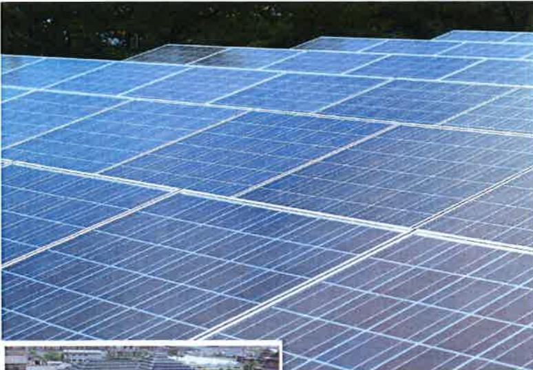
太陽から降り注ぐ光は、とても大きなエネルギーを持っています。この太陽光のエネルギーを電気に変えるものが太陽光発電です。通常の太陽光発電は、太陽光電池パネルで直流の電気に変換し、パワーコンディショナと呼ばれる装置で交流に変換して電気を使います。
